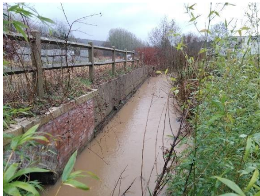
Berge maçonnée en rive du chemin de fer (SEGED, 2024)
