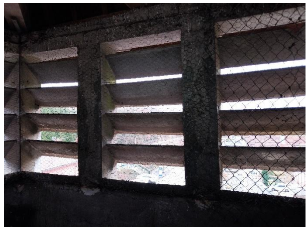
Vue des abat-sons équipés de grillages anti volatiles
