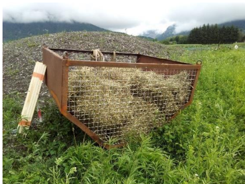
Exemple de filtre à paille prêt à installer
