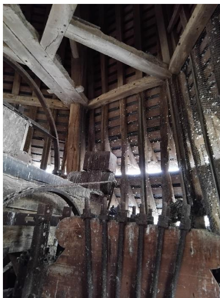
Aperçu des grillages anti volatiles mis en place (Source : ABO SEGED Environnement, le 12-03-2025)
