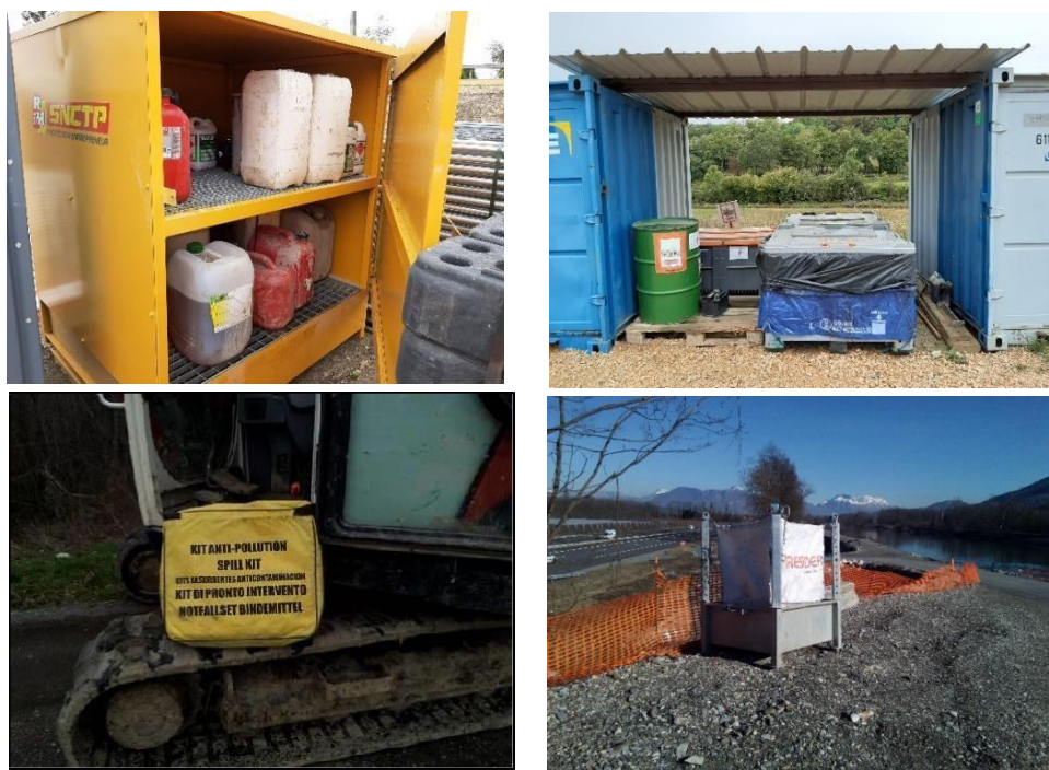
Exemples de mesures de prévention des pollutions : stockage de produit dangereux sur rétention et à l'abri des intempéries, kit anti-pollution, aire de lavage des toupies de béton.
