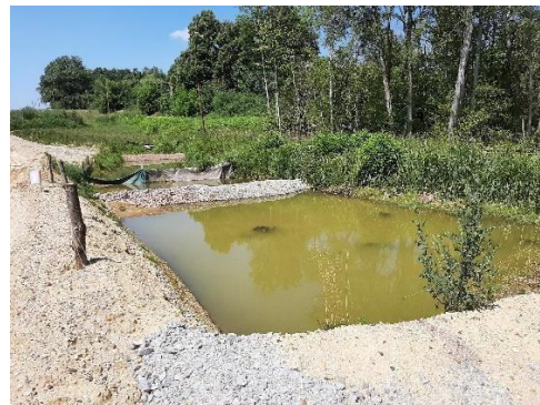
Bassin de décantation des eaux avec filtres intermédiaires et en sortie
