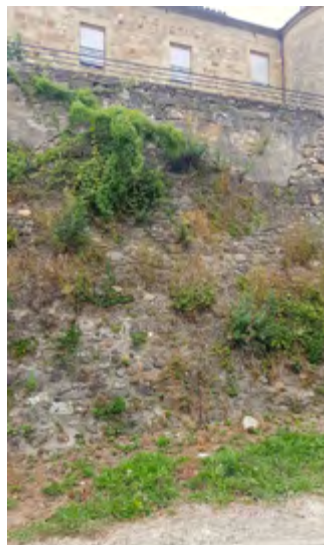
Mur de soutènement.
