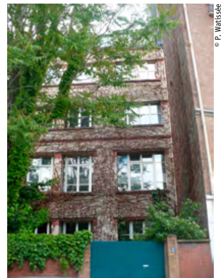
Façade dont les plantes grimpantes ont été éliminées
