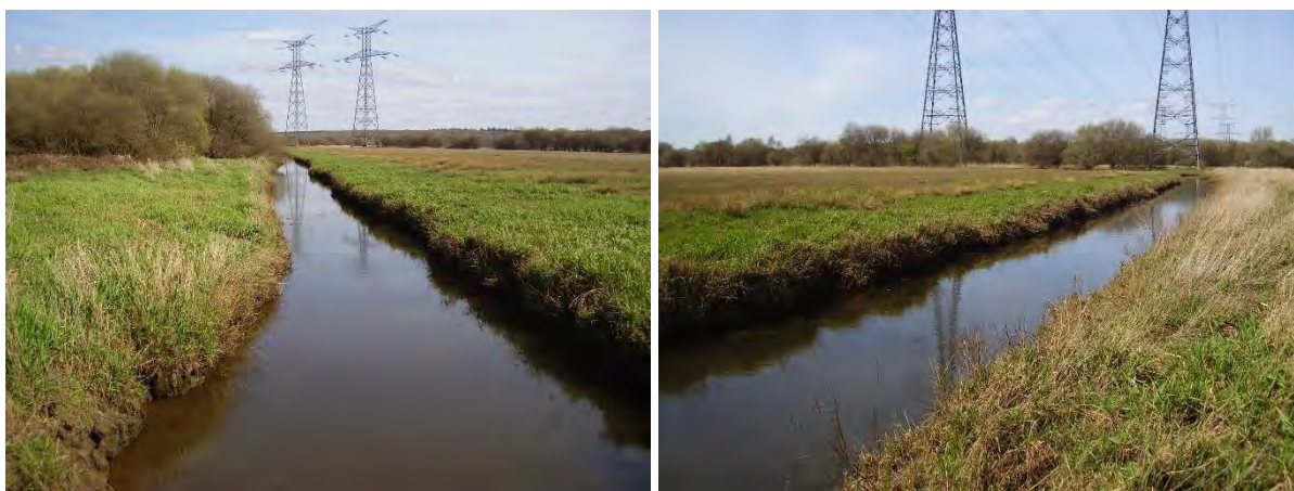
Aperçu du tronçon 7
