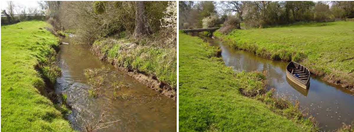
Aperçu du tronçon 5
