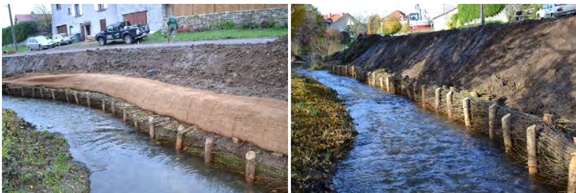
Exemples de réalisation de fascine de saule vivant
