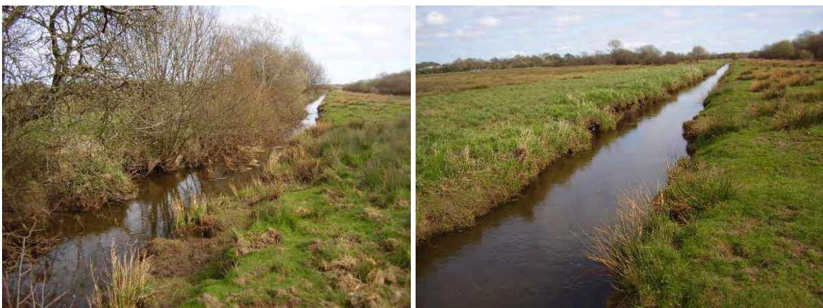
Aperçu du tronçon 2
