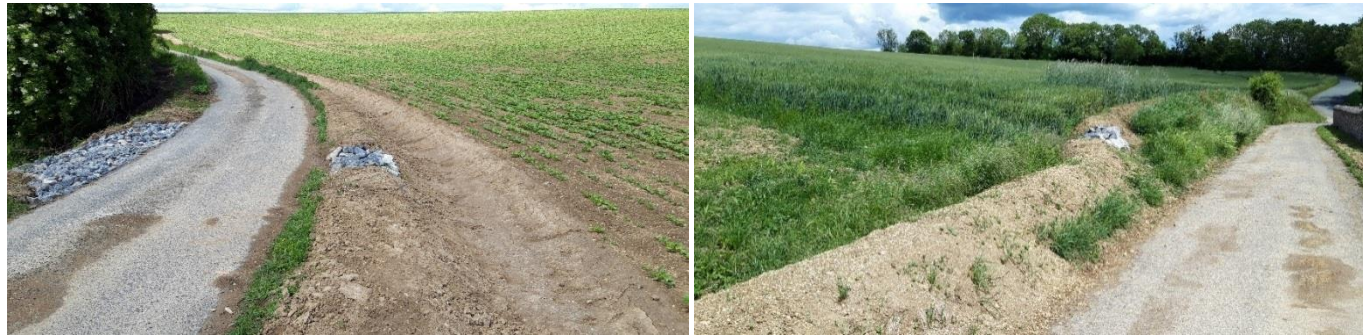
Schéma 32 : Série d'empochements alimentés par un « passage à gué » ou « cassis »
