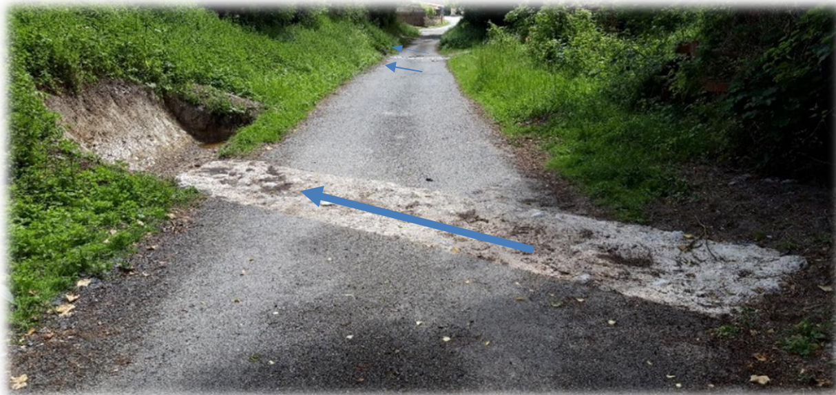
Schéma 32 : Série d'empochements alimentés par un « passage à gué » ou « cassis »
