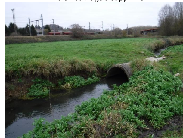
Buse à remplacer par une passerelle
