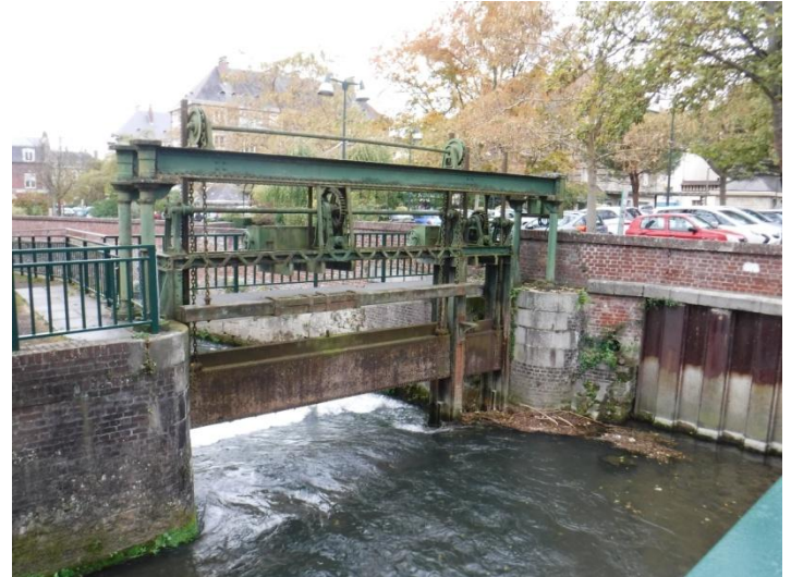
Figure 7 : Vue amont de l'ouvrage du Carmel
