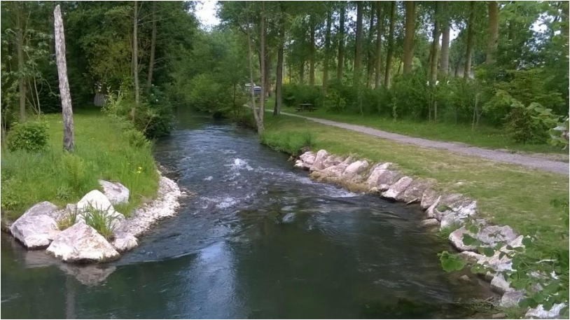
Exemple de rampe en enrochements avec passe à anguilles en rive droite, en eau (Source : CATER 76)
