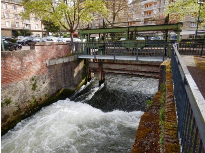
Figure 6 : Vue aval de l'ouvrage du Carmel (ARTELIA 2018)
