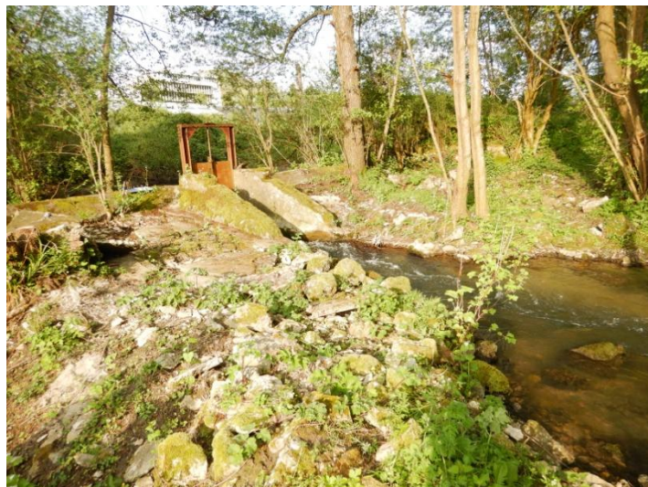
Figure 5 : Vue aval du vannage Orbiquet/Graindin depuis le Graindin (ARTELIA 2018)
