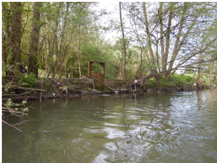
Figure 4 : Vue amont du vannage Orbiquet/Graindin depuis l'Orbiquet (ARTELIA 2018)
