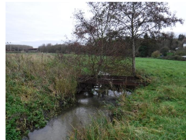
Ancien ouvrage à supprimer
