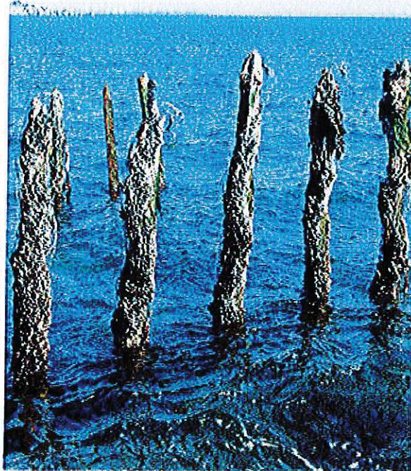
Etat des pieux après prédation (Autre exemple)
