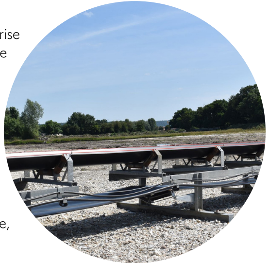
Installation de bandes transporteuses / L. Lemonnier
