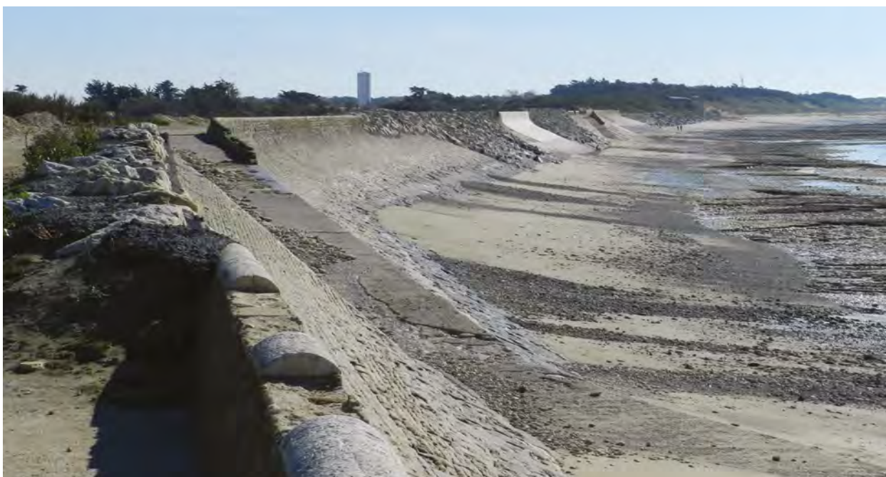
Photo 9 : Les travaux de réparation très hétérogènes entrepris sur la digue des Doreaux à Saint-Clément-des-Baleines (17), avec entre autres une dalle bétonnée, un essai en pierre sciée (section claire en bout de digue), du rejointoiement grossier et un état global médiocre
