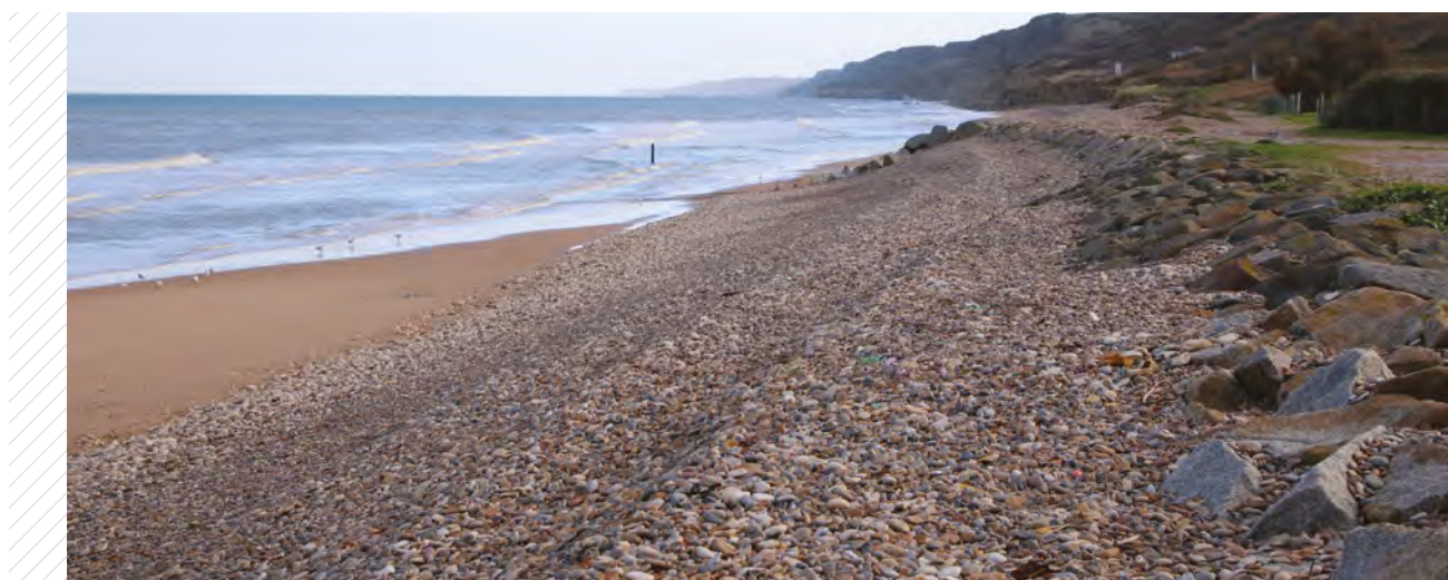
Photos 11 et 12 : Site d'Omaha Beach (14) : la digue a été prolongée, et l'abaissement de la plage a conduit à protéger son pied par un enrochement, qui plus est de couleur noire. Plus loin, le cordon de galets.
