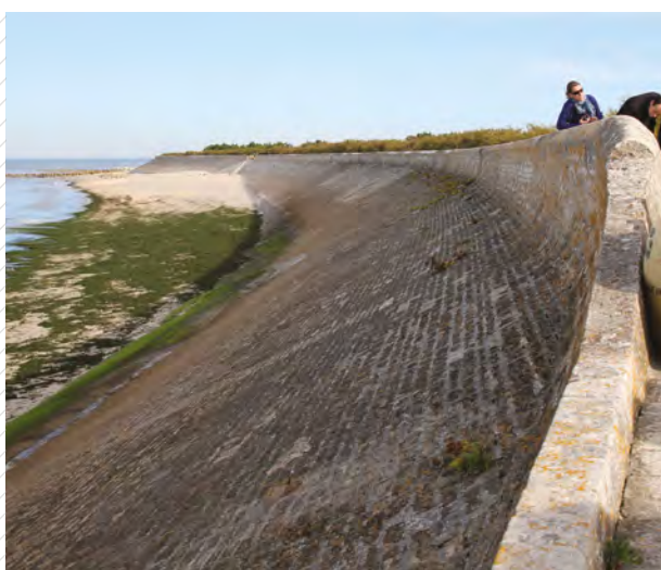
Photo 10 : Loix, île de Ré (17) digue maçonnée avec un couronnement arrondi, un haut de mur vertical, le pas d'accès est équipé d'un petit muret de bordure
