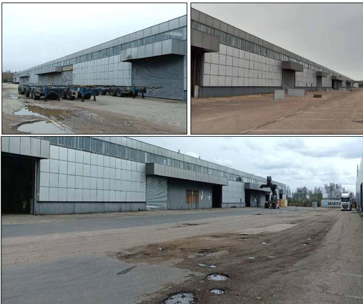
Figure 2 : De haut en bas et de gauche à droite : façade ouest du bâtiment A, façade nord du bâtiment BC et façade ouest du bâtiment D
