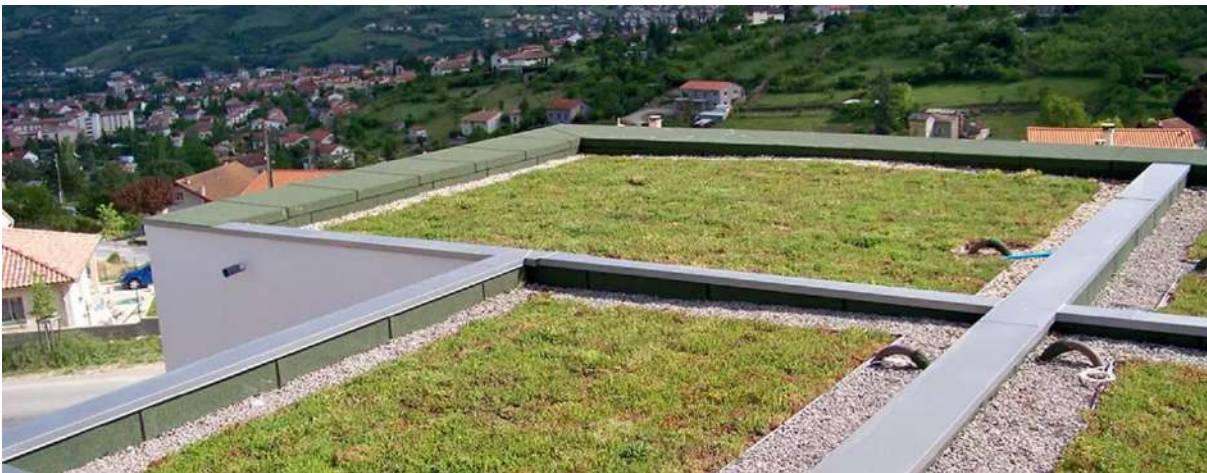
Figure 26 : Exemple de toiture végétalisée de type TOUNDRA
