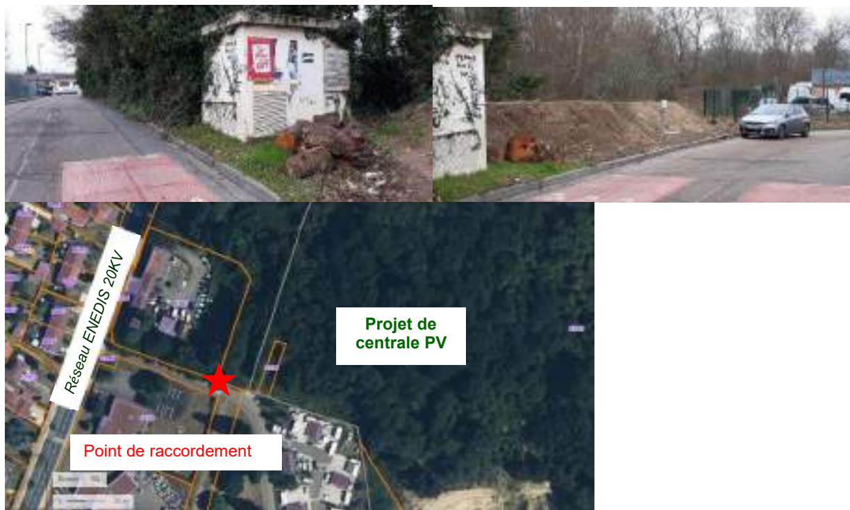
Solution de raccordement en plein réseau sur un départ HTA situé à environ 50 m du terrain du projet (Source : Oissel Energies)
