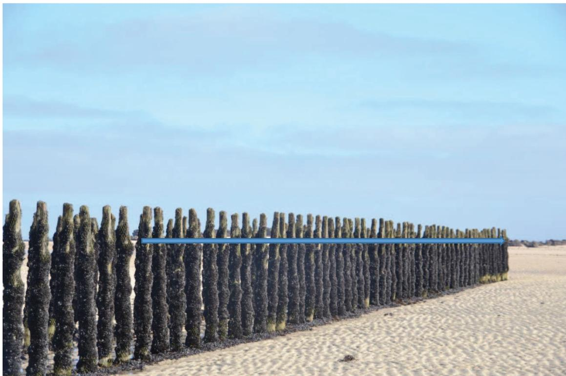
J'observe de très importantes dégradations avec des pertes qui peuvent être chiffrées à environ 25 à 30 % de la hauteur des pieux.
