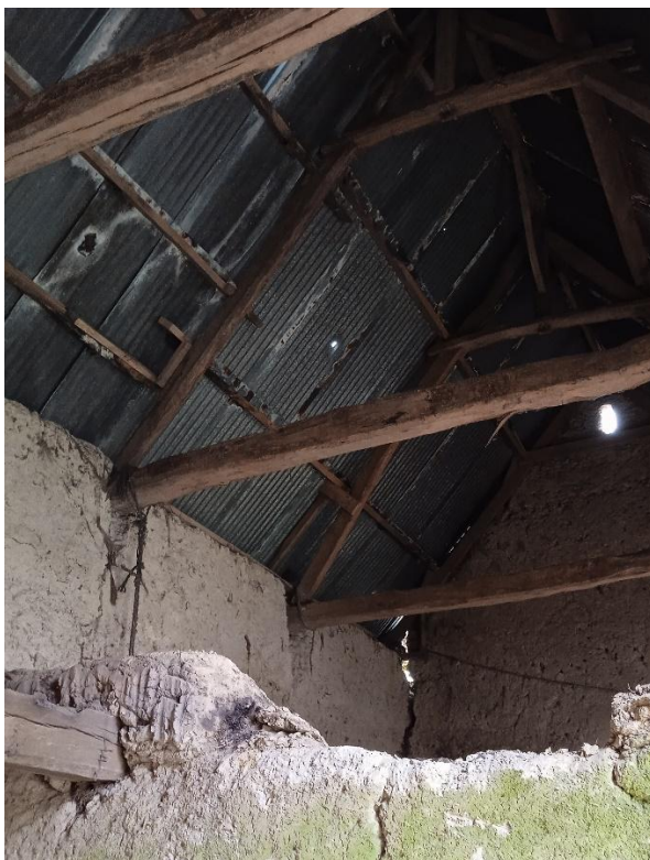
Photo 12 : Bâtiment AH182 (© Rainette, 2023)
