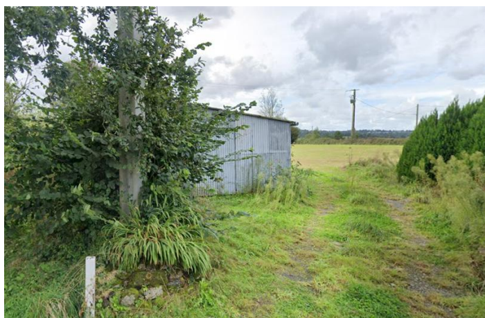
Photo 16 : Bâtiment AA36 (Google Street view)
