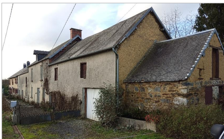
Photo 24 : Bâti de la propriété ADI52
