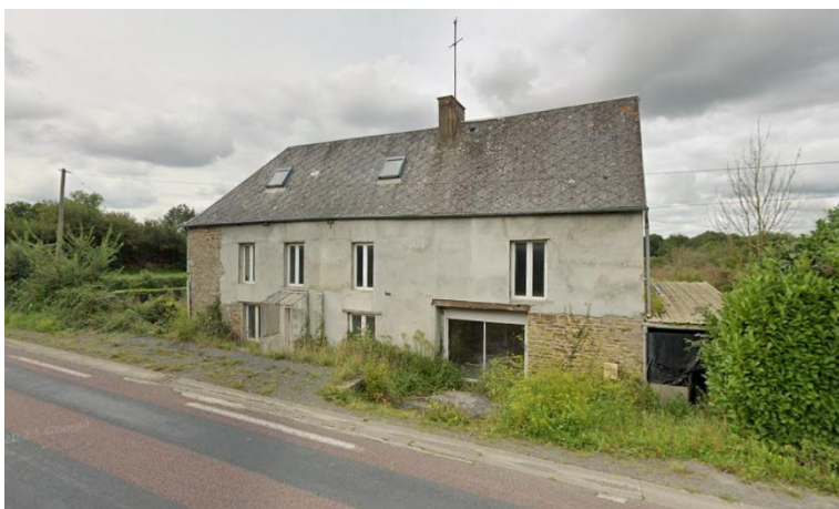
Photo 17 : Bâtiment B199.1 (Google Street View) avant démolition
