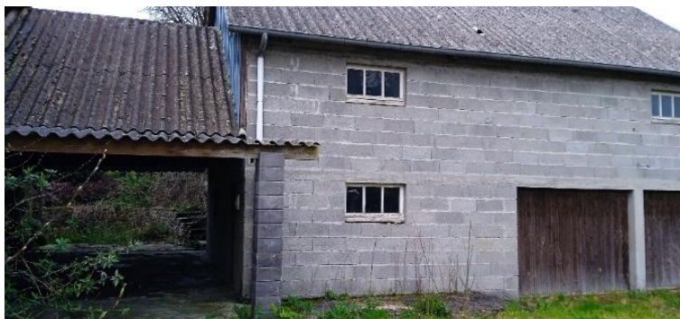
Photo 1 : Bâtiment 8.2 et « porche » rattaché à gauche au 8.1
