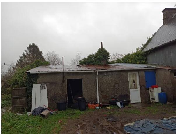
Photo 14 : arrière du bâtiment AH3 © Rainette 2023
