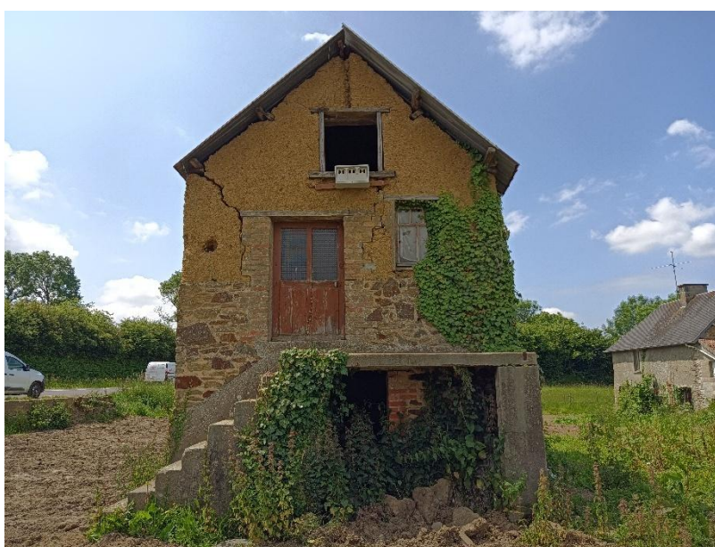
Photo 18 : Dépendance B199.2 en juin 2024 (avec nichoir à moineaux) après démolition de B199.1 © Rainette
