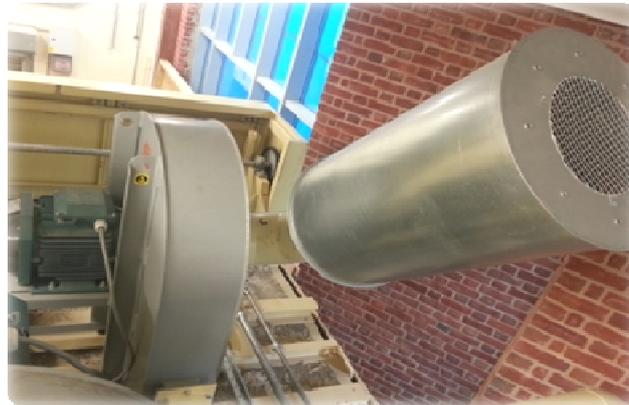
Chaque équipement de crémation est équipé d'un ventilateur qui produit l'air nécessaire au bon déroulement d'un cycle de crémation à savoir :
