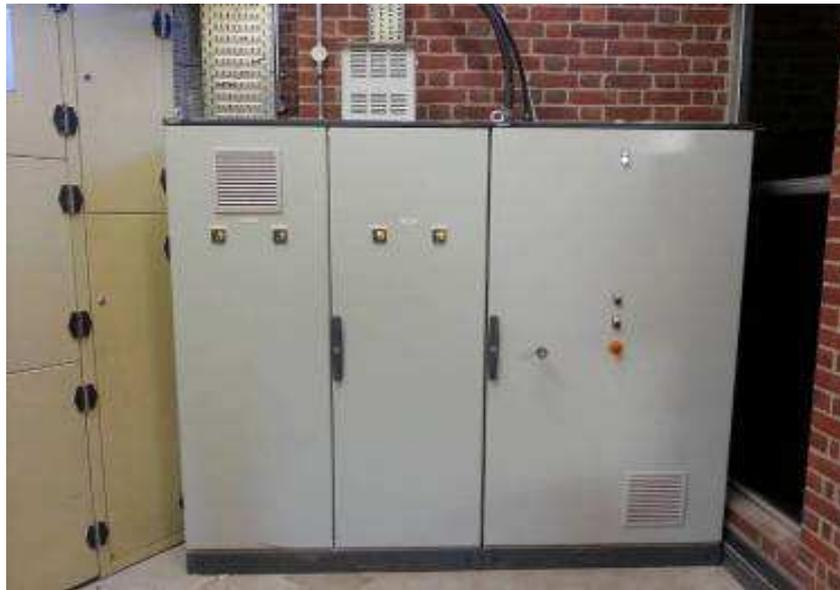
L'ensemble four et ligne de filtration simple sera géré par un automate programmable de marque « télémécanique » équipé d'un principe évolutif afin de gérer en toute sécurité le contrôle automatique du tirage, des températures en chambre principale et secondaire en cas de surchauffe ou de surpression.
