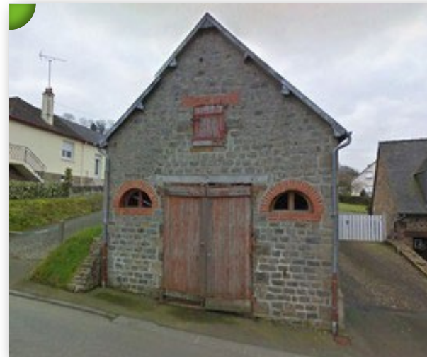
Maisons en granit à Tinchebray-bocage, toitures en ardoises. Parements en moellons, usage de blocs de granit taillés pour les chaînages et encadrements. Mélange de granit clair et granit ferrugineux plus sombre. Grange en granit avec usage de la brique pour les encadrements à Lonlay-l'Abbaye.
