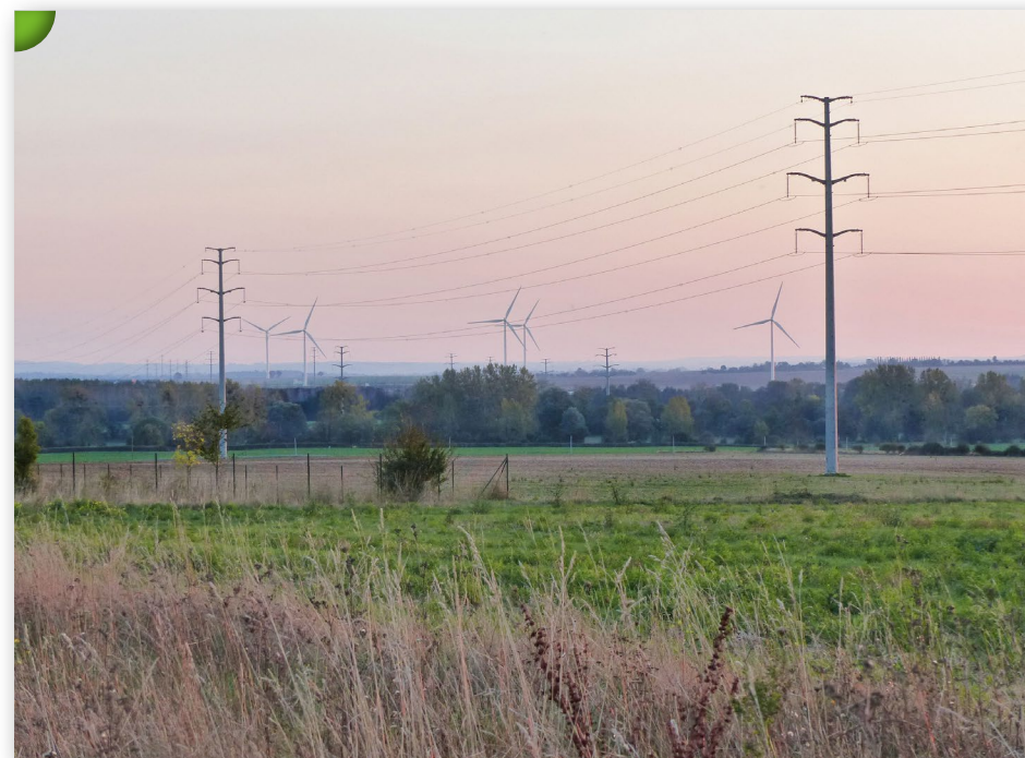
Couloir bocager, éoliennes et lignes à haute tension.
