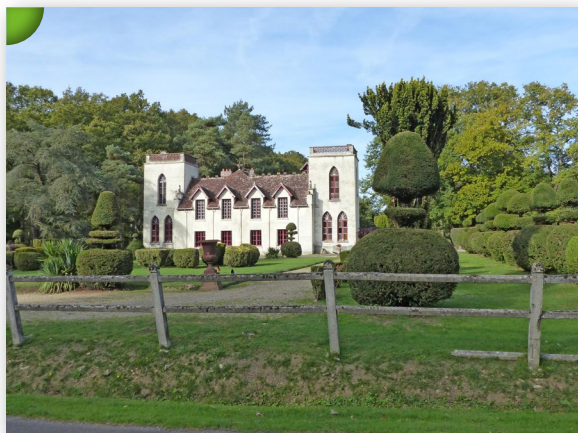
Château associant des typologies traditionnelles (partie centrale avec lucarnes sous tuiles plates) et néo-gothiques (avec façade blanchie, tourelles section carrée et ouvertures en ogive sous toit-terrasse) Château du bois de Peley ; Almenèches.
