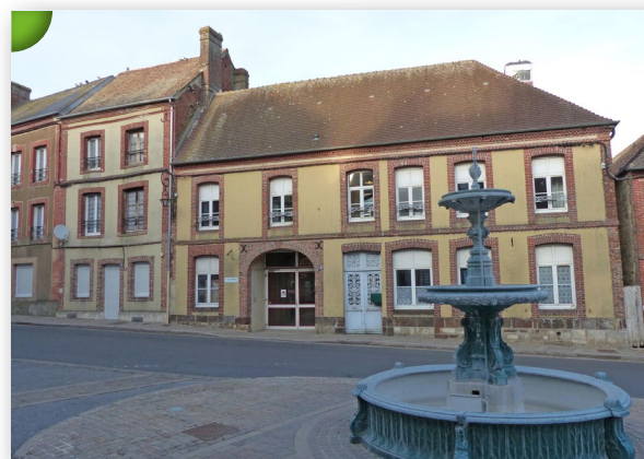
Maisons de ville avec enduits clairs, soubassements en pierres de taille, encadrements, bandeaux, jambages, corniches en briques sous tuile ; Moulins-la-Marche.
