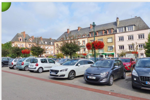
Place de La Libération à Gacé : front urbain issu de la reconstruction. Bien que la brique et l'ardoise dominent, le traitement des façades reste hétéroclite : enduits peints, moellons de granit. La tuile et les pans de bois sont plus rares. Notons la forte présence de la voiture sur l'espace public.
