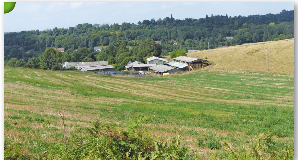
Bâtiment agricole récent construit en extension du corps de ferme ancien et bien intégré au paysage en creux de vallon ; la Foutelaie sur la RD 246.
