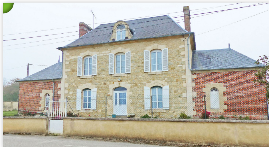
Bâtisse en moellons de calcaire avec encadrements et chaînages d'angles en pierres de taille. Ailes de la bâtisse en briques avec encadrements en granit sous ardoises. Sur la RD 26 vers Survie.
