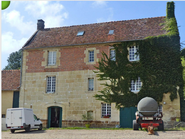
Bâtisse en pierres de taille calcaire avec soubassements en granit à proximité de la ferme du Vimer.
