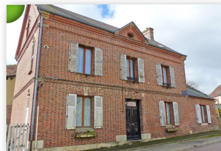
Présence de maisons en briques comme ici sur la Commune d'Échauffour.
