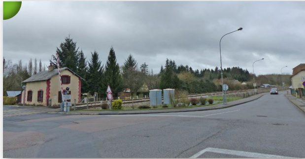
Exemple d'une maison de garde-barrière, au croisement entre la RD 220 et la RD 669 au niveau de Rai.
