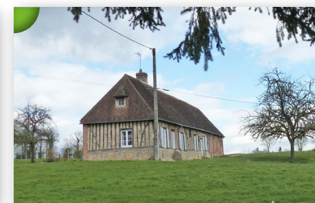
Maison couverte de tuiles brunes, isolée sur une parcelle, alliant une partie à pans de bois et pierres, et une partie en briques plus récente, vers La Pretrière ; commune de Bocquencé.
