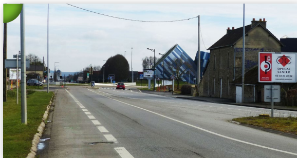
Vue de la départementale 112 à l'ouest d'Alençon. Entrée de ville peu qualitative avec un bâti qui ne présente aucune harmonie d'ensemble.
