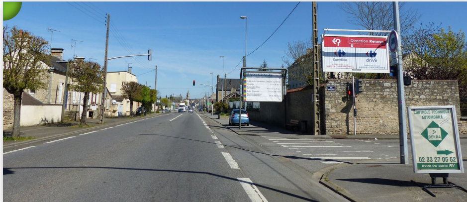
RD 338 - Voie rectiligne à l'entrée sud d'Alençon. Le traitement routier peu qualitatif de cet espace crée une rupture nette et large dans la ville et pas du tout propice à la promenade.
