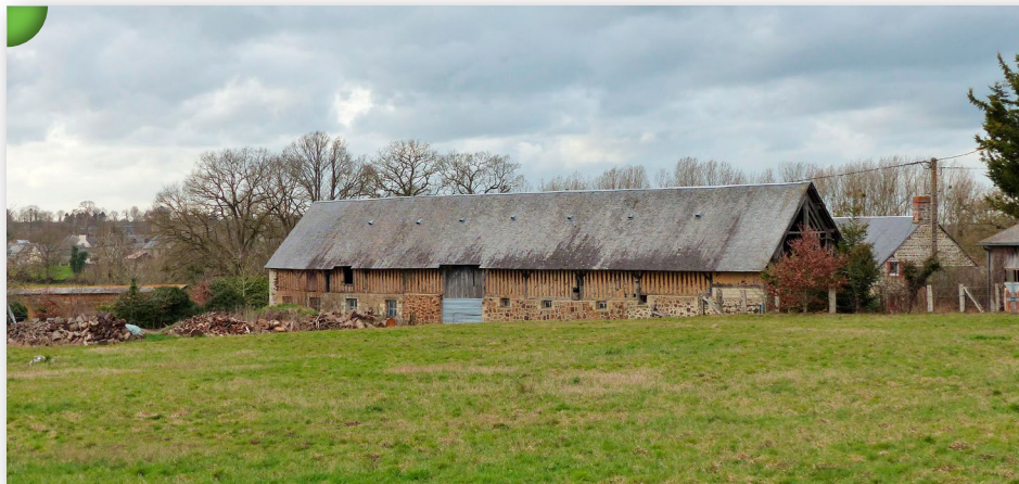
Imposante grange en pans de bois et cadre de terre sur un soubassement en granit, intégrée à la pente, RD 32, Le Teilleul.
