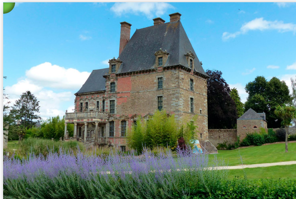
Château des Montgomery, implanté en cœur de bourg et entouré de larges parterres plantés et engazonnés, Ducey-les-Chéris.
