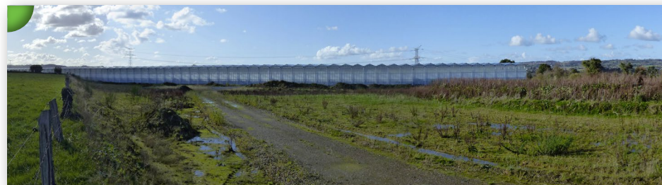
Perspective fermée par le prolongement monumental des serres, implantées au sein d'une vaste parcelle de la plaine alluviale, la Doisnellière, Brécey
