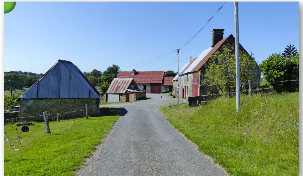
Ferme organisée autour d'une cour ouverte, implantée en partie haute du coteau, lieu-dit la Ménardière, Sourdeval.
