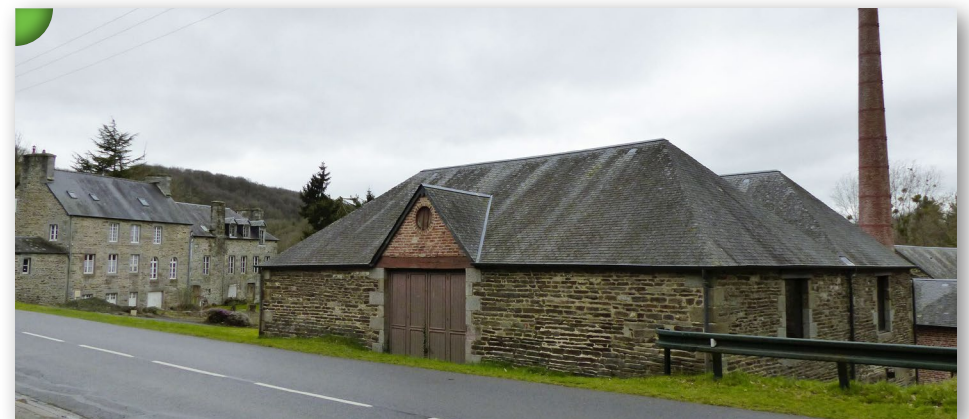
Le moulin de la Sée situé en entrée des petites gorges, RD 911, Brouains
