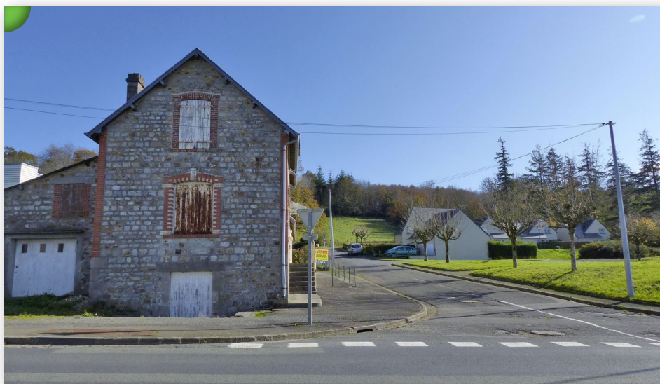
Maison ancienne abandonnée au premier plan et nouveau petit quartier résidentiel en arrière-plan, RD 157 au nord du centre de Mortain-Bocage.
