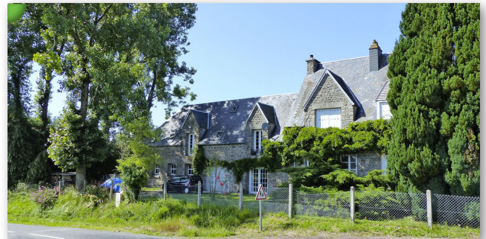
Bâti traditionnel à la Tournerie, Saint-Barthélemy. Construction en grès armoricain, toiture en ardoise, lucarne fronton en appui de la façade et linteaux en pierre de taille.
