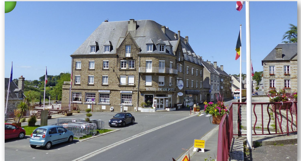
Le bâti issu de la Reconstruction s'inspire dans ses formes du bâti traditionnel et mélange granite, grès et béton, Mortain.
