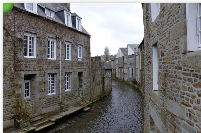
Anciens ateliers construits le long de la Sienne canalisée (bief du Moulin du Commandeur), Villedieu-les-Poêles.
