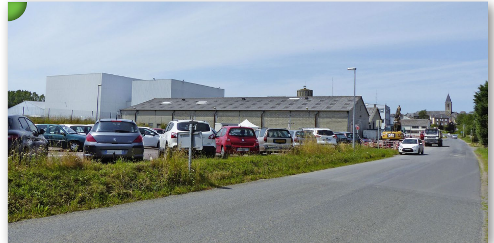
Zone d'activités située au sein du fond de vallée de la Vire, RD 86, Condé-sur-Vire.
