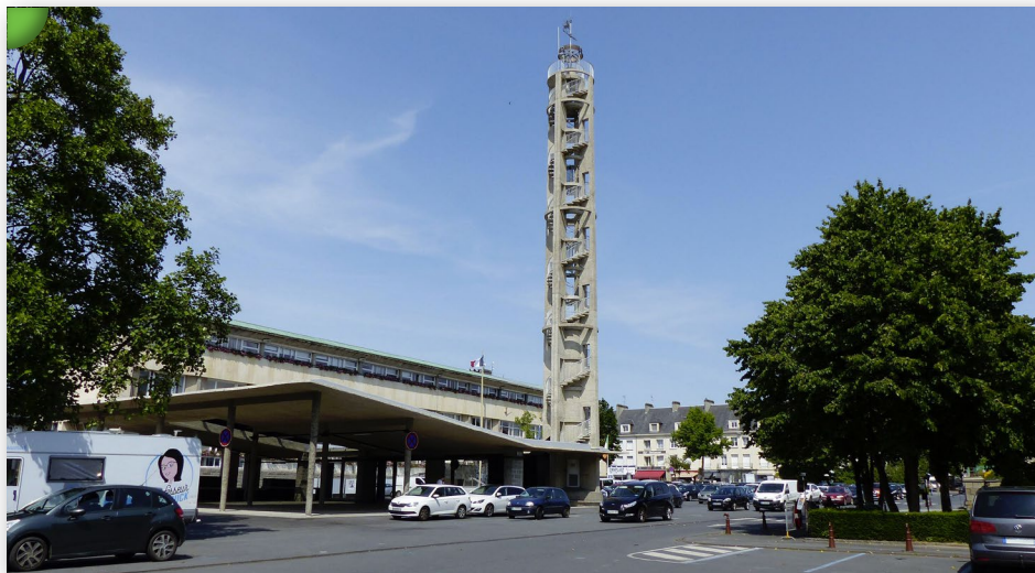
Ensemble architectural regroupant les halles, l'hôtel de ville et le beffroi de Saint-Lô, façonnant une place publique rythmée par des espaces végétalisés avec de beaux sujets mais où l'automobile est omniprésente, place Général de Gaulle, Saint-Lô.
