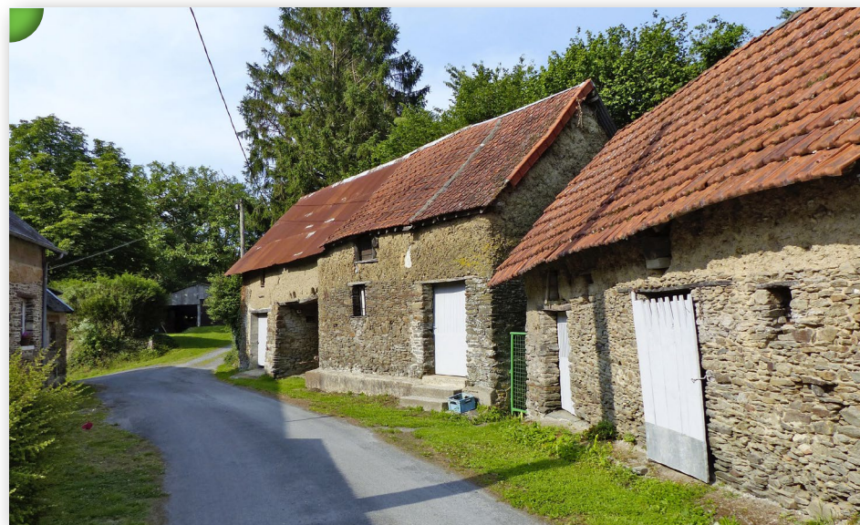
Ancien corps de ferme en terre sur soubassement de pierre, Lieu-dit Hôtel Durant, Villiers-Fossard.
