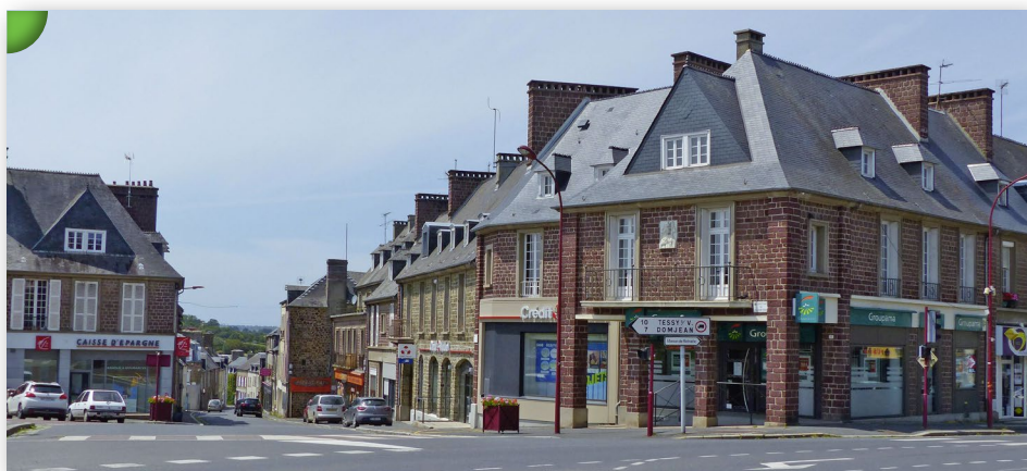
Immeubles de la Reconstruction avec parements en poudingue ou en grès, Rue de Robert du Mont, Torigni-sur-Vire.
