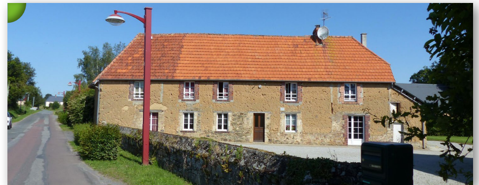
Maison en « mâtse », avec soubassement en calcaire et encadrements de brique, RD 94, Marchésieux.
