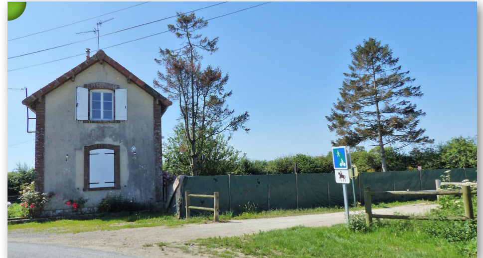
Passage de l'ancienne voie ferrée convertie en voie verte, de Carentan à La Haye-du-Puits, bordée de la maison du garde-barrière, hameau la Ferme d'Aussaye, Méautis.
