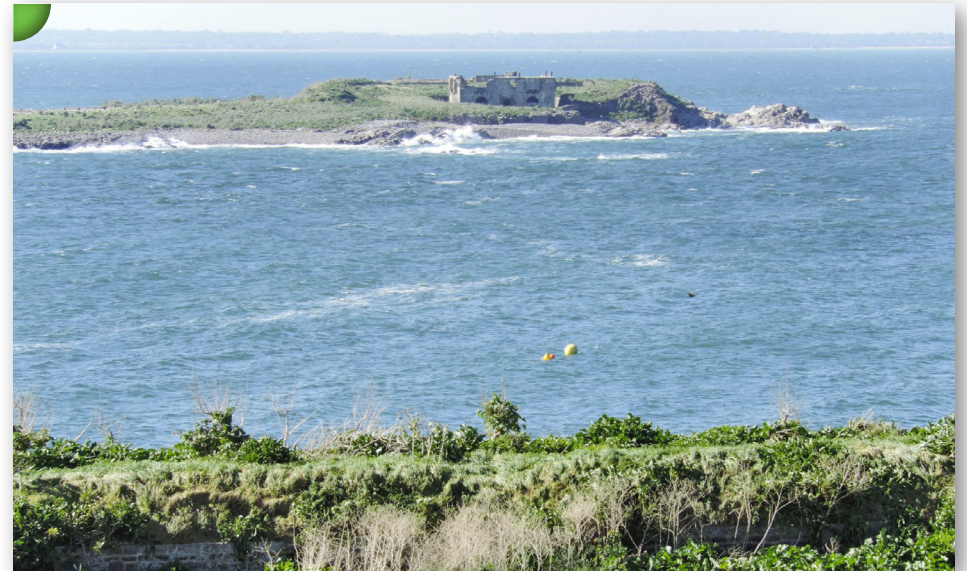
Vue de la batterie aménagée sur l'Île de Terre.
