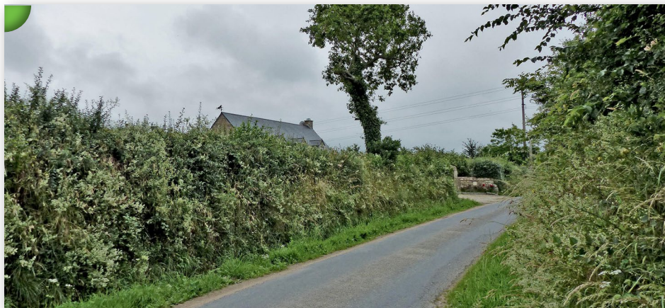
Route bordée de talus plantés d'une haie basse, vues assez fermées, hameau Moquet, Tréauville.
