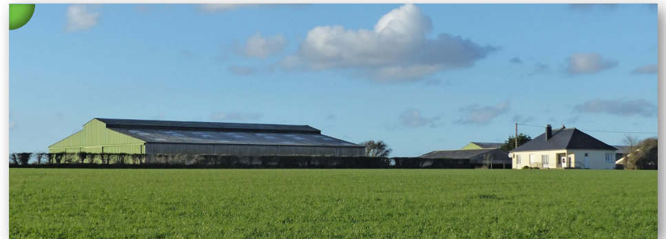
Grand hangar aménagé aux abords de la ferme originelle, route de Saint- Paul, Baubigny.
