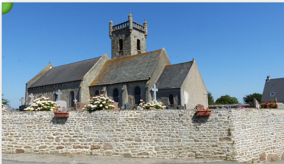
Eglise Saint-Martin et de la Sainte-Trinité typique de la côte basse, dont le clocher est carré et fortifié avec guet et échauguettes. Eglise et son cimetière cernés d'un haut mur bâti en moellons de granit gris-brun, Vicq-sur-Mer.
