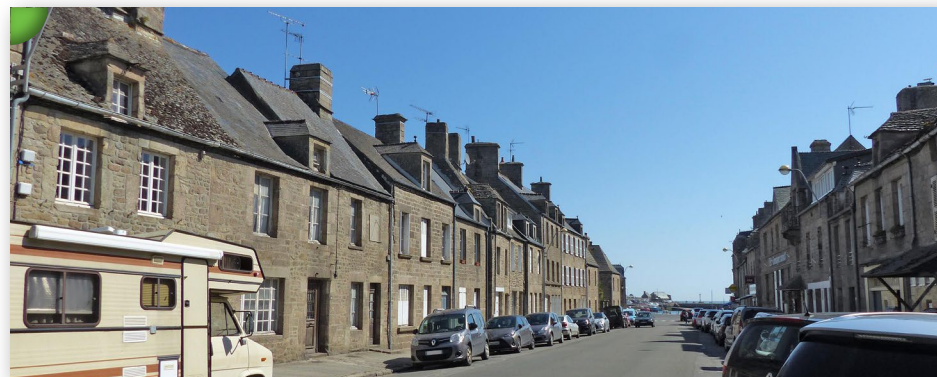
Linéaires de façades mitoyennes du bourg de Barfleur sur la D1, s'étirant en direction du front de mer.
