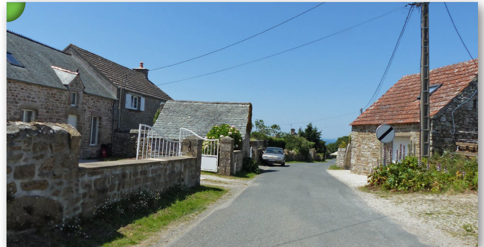
Hameau rural de la Place, composé de maisons mitoyennes en granit, alignées perpendiculairement au trait de côte afin de se protéger des vents marins, Maupertus-sur-Mer.
