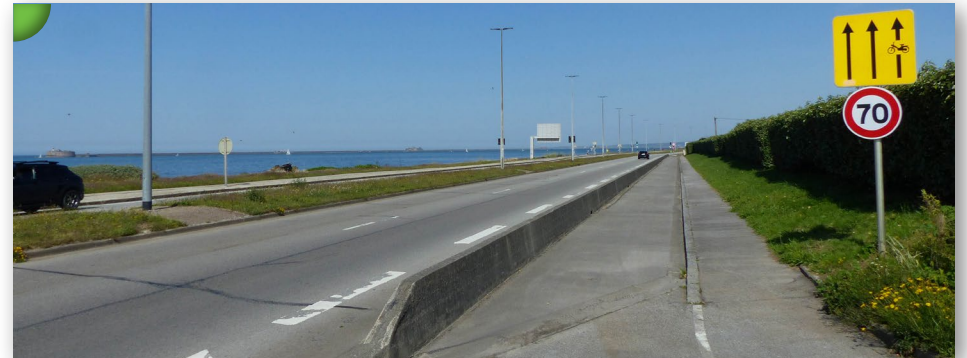
RD901 le long de la rade, dans la périphérie ouest de Cherbourg : traitement routier peu qualitatif sur les rives de la grande rade.
