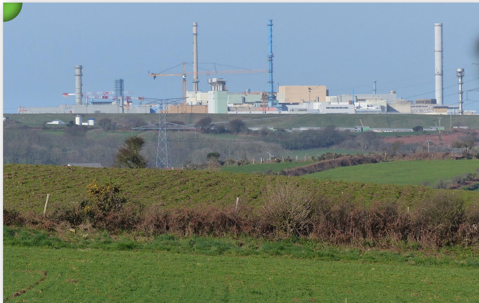
Vue prégnante sur l'usine ORANO depuis le nord-est du plateau.
