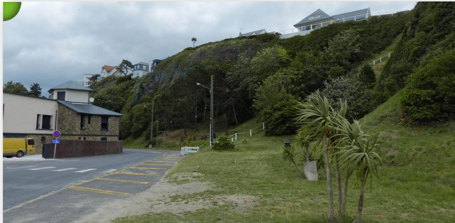
Rue de la plage dominée par les falaises sur lesquelles les quartiers résidentiels se sont établis, Donville-les-Bains.
