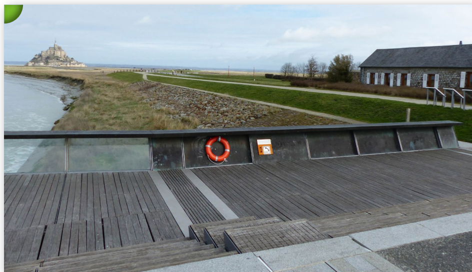
Vue sur le circuit d'accès au Mont Saint-Michel depuis le barrage du Couesnon, la Caserne, Le-Mont-Saint-Michel.
