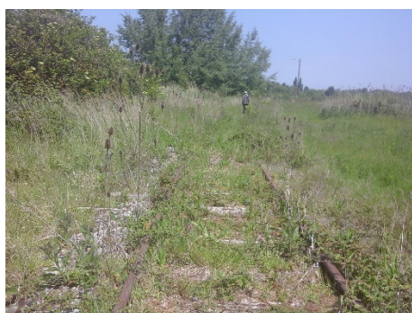
Ancienne voie ferrée
