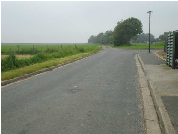
③ abord ouest prairie, côté chemin rural vue vers le sud
