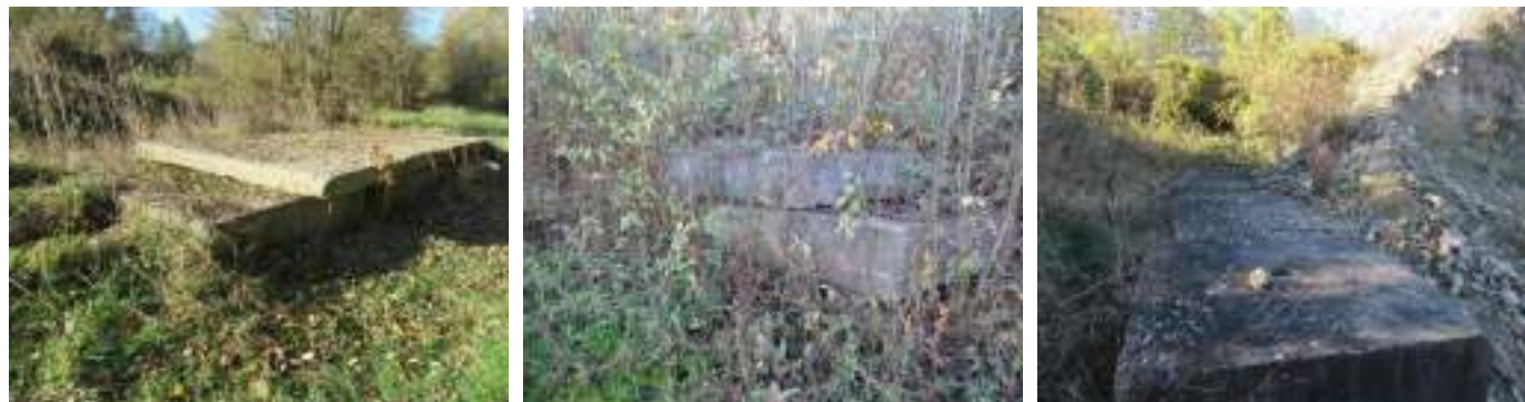
Blocs en béton présents sur le site d'étude Coralie BONJEAN (ALISE), 23-11-2021
