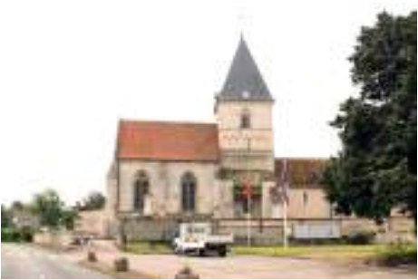
MH1 - Eglise Notre-Dame Source : ARTIFEX 2021
