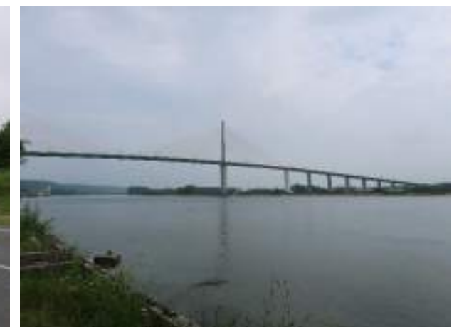
Pont de Brotonne
