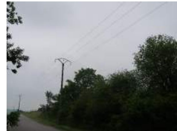
Ligne électrique le long de la bordure Nord du site d'étude Source : ARTIFEX 2021
