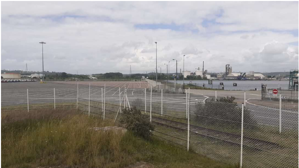
Photo 2 : Vue sur le puits d'entrée du microtunnelier et le Grand Canal du Havre. GRTgaz, 8 Juin 2022.
