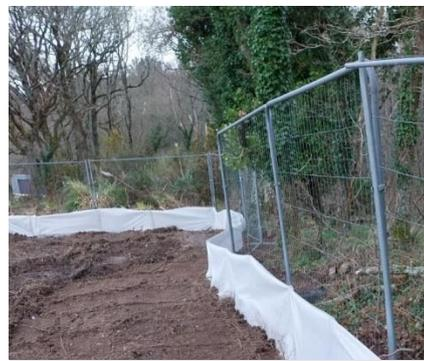
Exemple d'aménagement d'une barrière anti-intrusion en phase d'exploitation avec un voile géotextile et une issue permettant aux espèces présentes dans le périmètre travaux de sortir sans pouvoir revenir
