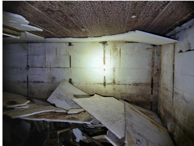
*Vue intérieure du blockhaus nord : de nombreux déchets seont présents et nécessiteront d'être évacués. Des « trous » nécessiteront d'être rebouchés. La mise en place de supports d'accroches divers sera nécessaire.*
