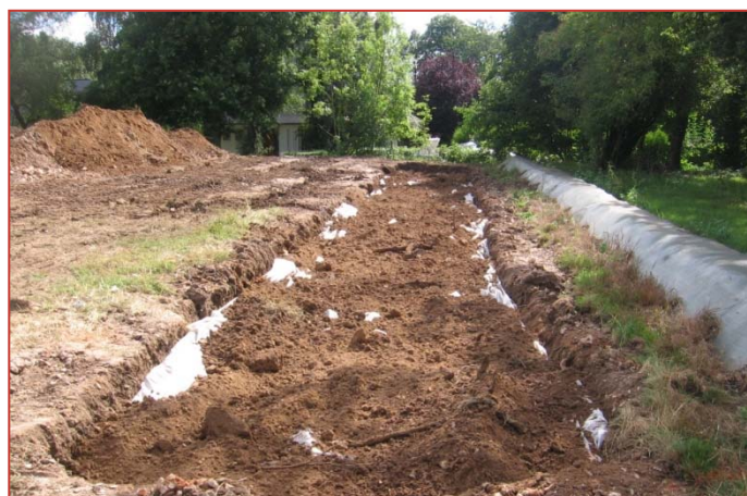
Mise en place du géotextile et de la terre végétale
