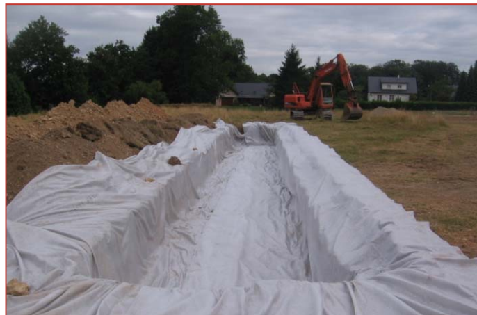
Mise en place du géotextile
