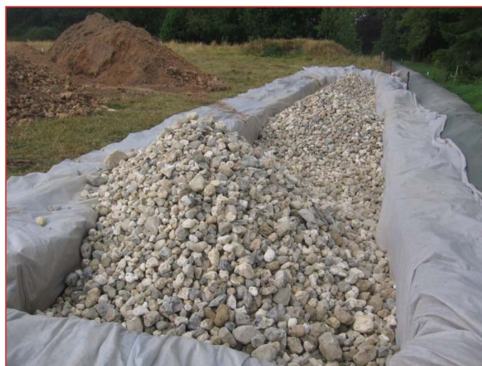
Mise en place du géotextile
