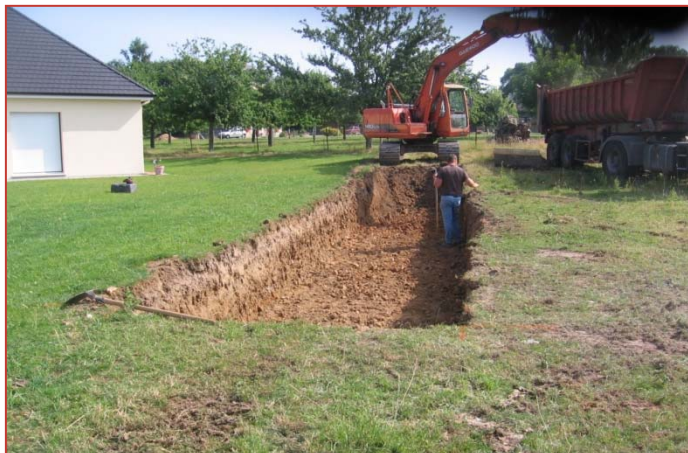
Terrassement du massif drainant
