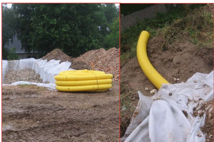
Installation de la canalisation de drainage
