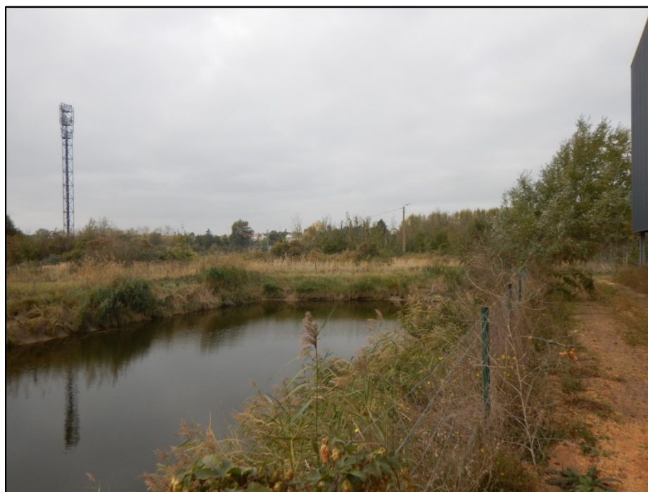
Fig. 7. Bassin EP existant à l'extrémité Sud du quai (Bâtiment T7 de Biocombustible)
