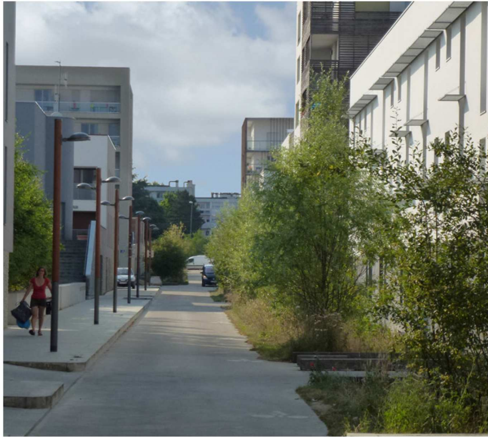
Voie béton + noue monolatérale + passerelle béton
