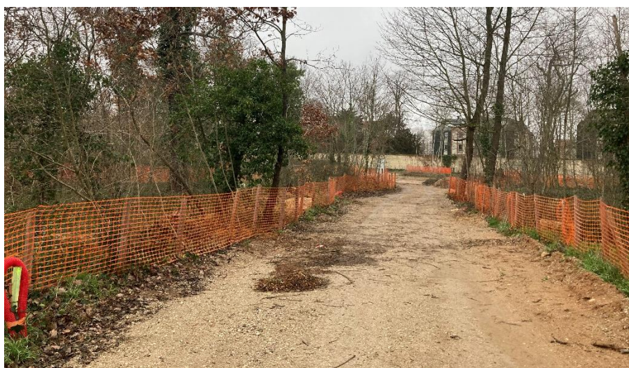
Figure 39 : Balisage de zones arborées à conserver sur un chantier d'Île-de-France © ARP-Astrance 2021
