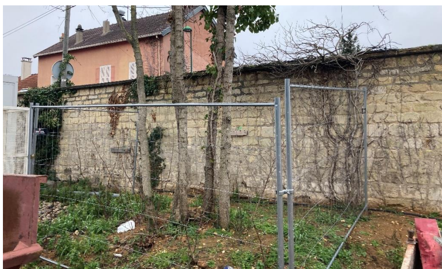
Figure 38 : Balisage d'arbres à conserver sur un chantier d'Île-de-France © ARP-Astrance 2021
