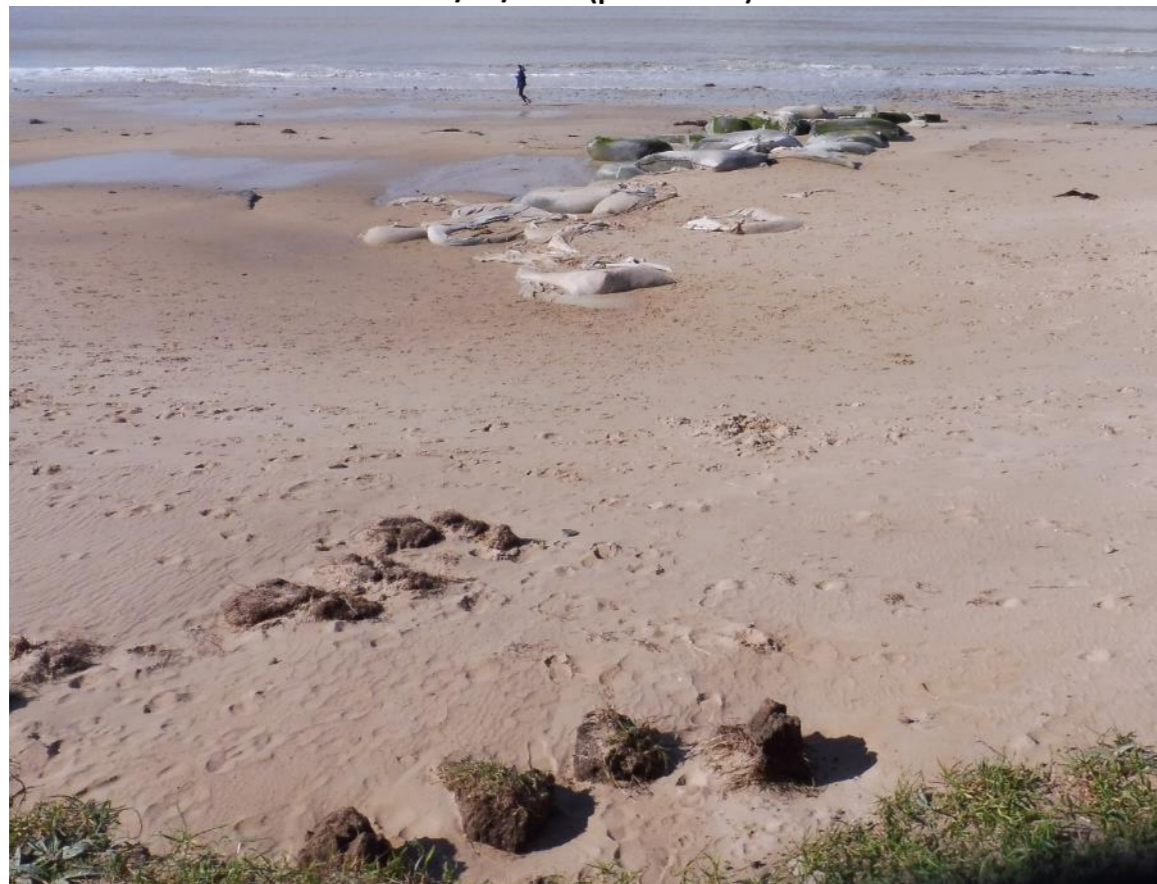
Le 16/03/2020 – après une marée de coefficient 117 et un rechargement en sable de 3 000 m 3 Secteur le plus à l'aval du projet de rechargement de 15 000 m 3 , vue vers l'ouest (photo n°1c)
