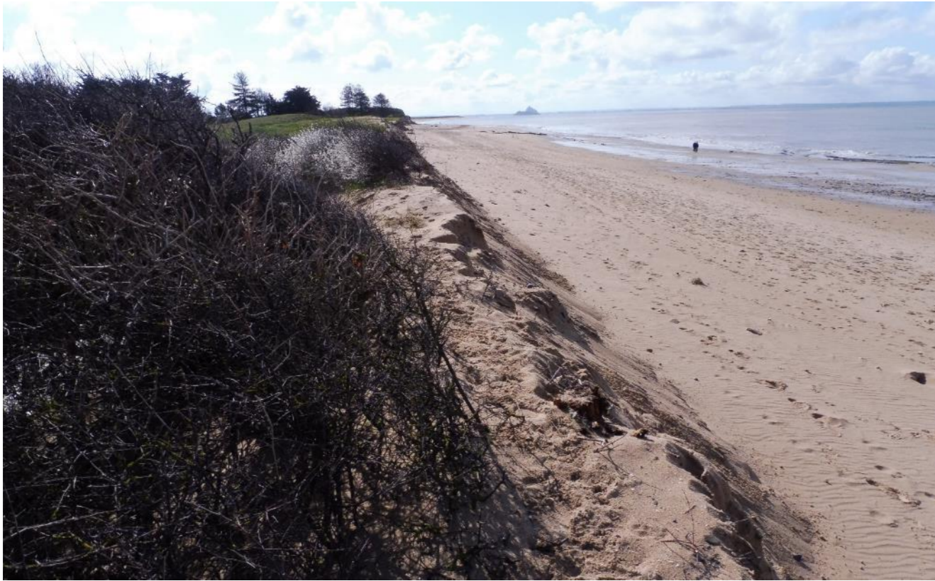
Le 16/03/2020 – après une marée de coefficient 117 et un rechargement en urgence en sable de 3 000 m 3 Vue d'une partie de la zone de rechargement de 15 000 m 3 au niveau de la zone de cordon dunaire la plus étroite (15 m) - Photographie vue vers le sud (photo n°5)
