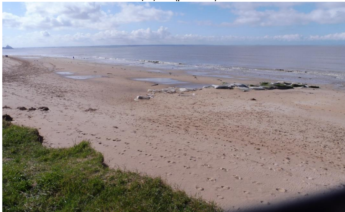
Le 16/03/2020 – après une marée de coefficient 117 et un rechargement en sable en urgence de 3 000 m 3 Recul du cordon dunaire au niveau de l'épi : La distance entre l'épi et le cordon était de 11.5 m le 03/03/2020 et 13 m le 16/03/2020. Secteur le plus à l'aval du projet de rechargement de 15 000 m 3 , photographie vue vers le sud-ouest (photo n°2c)
