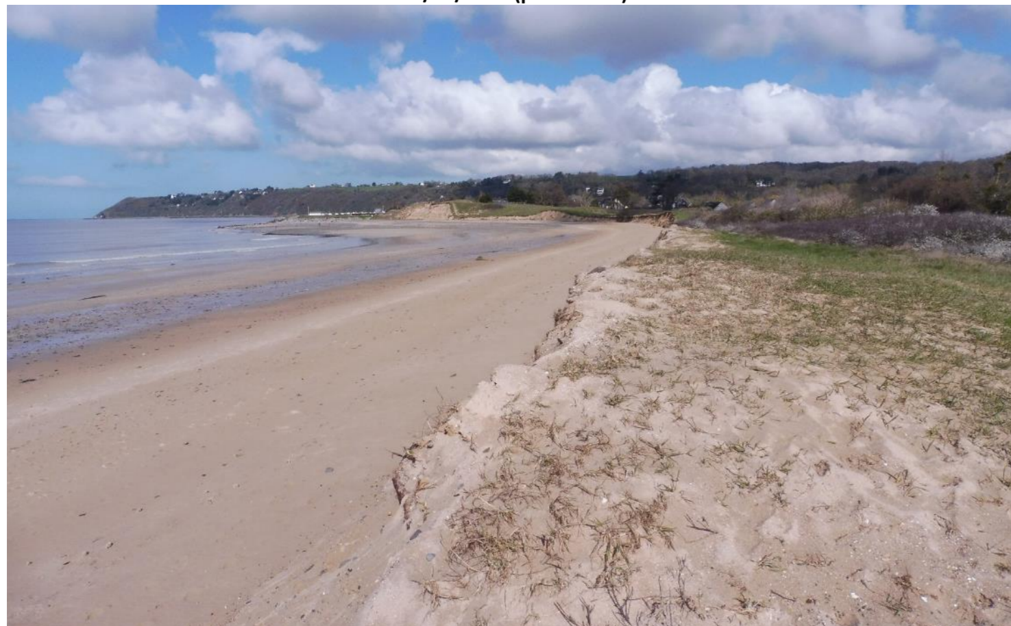
Le 16/03/2020 – après une marée de coefficient 117 et un rechargement en sable de 3 000 m 3
