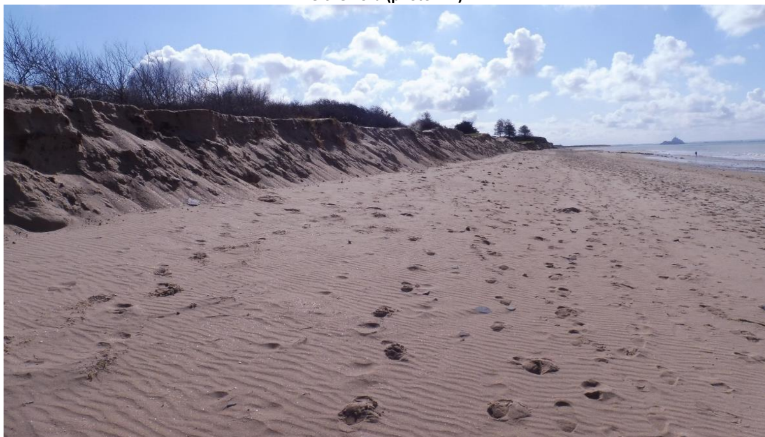
Le 16/03/2020 - Vue de la partie sud du rechargement depuis le pied du cordon dunaire - Photographie vue vers le sud (photo n°8)
