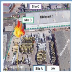
Stockages extérieurs proches des bâtiments
