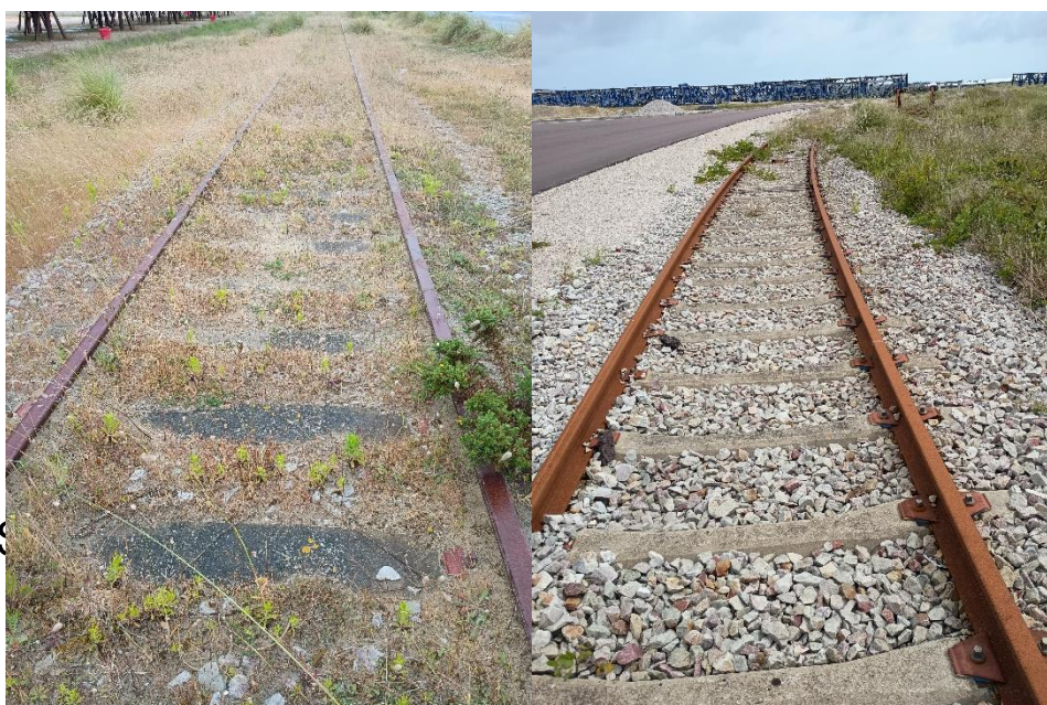
FIGURE 9 : ANCIENNES VOIES FERREES(©EGIS)
