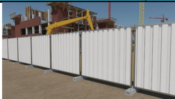
PHOTOGRAPHIE 30 : EXEMPLES DE BARRIÈRES DE CHANTIER
