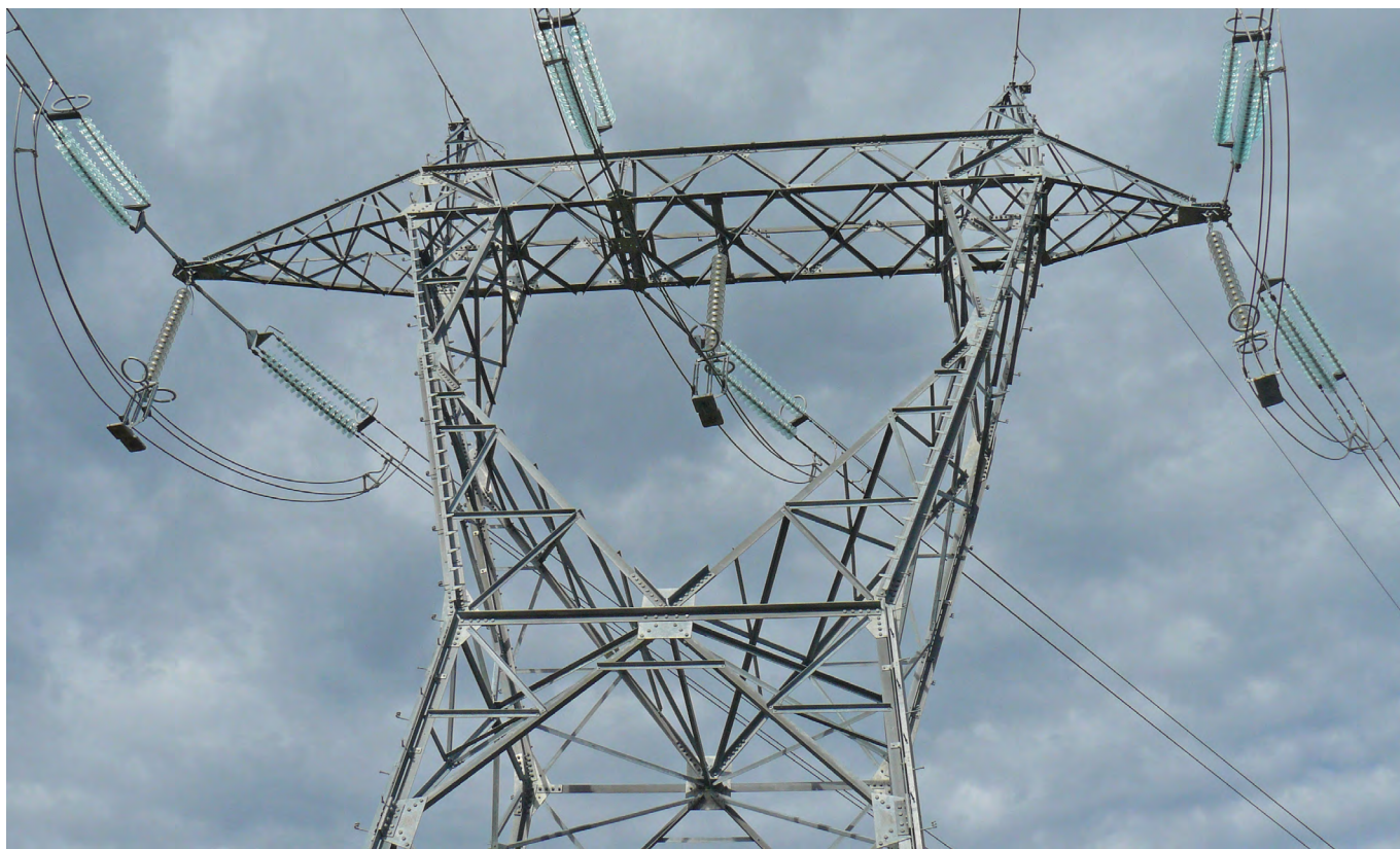
Ligne très haute tension du poste de Taute (50)
