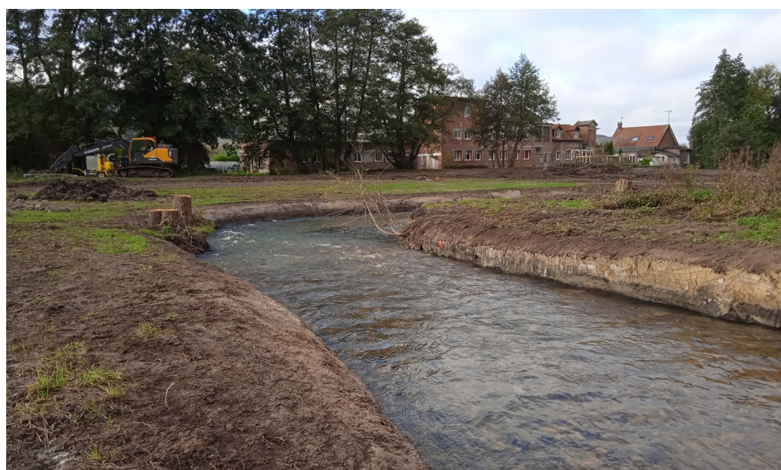
Après travaux, mise en eau du nouveau bras de l'Eaulne à Bellengreville (76)
