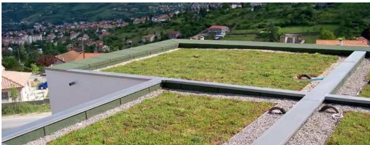
Figure 4 : Exemple de toiture végétalisée de type TOUNDRA
