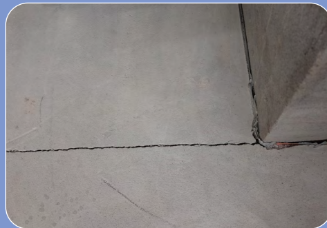
Fissure de la dalle béton
