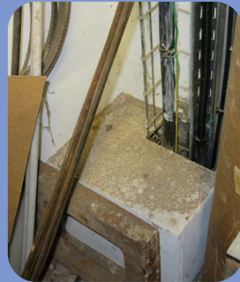
Passage de réseau VRD non étanche
