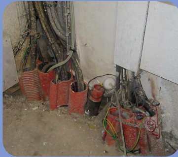
Passage de réseau VRD non étanche
