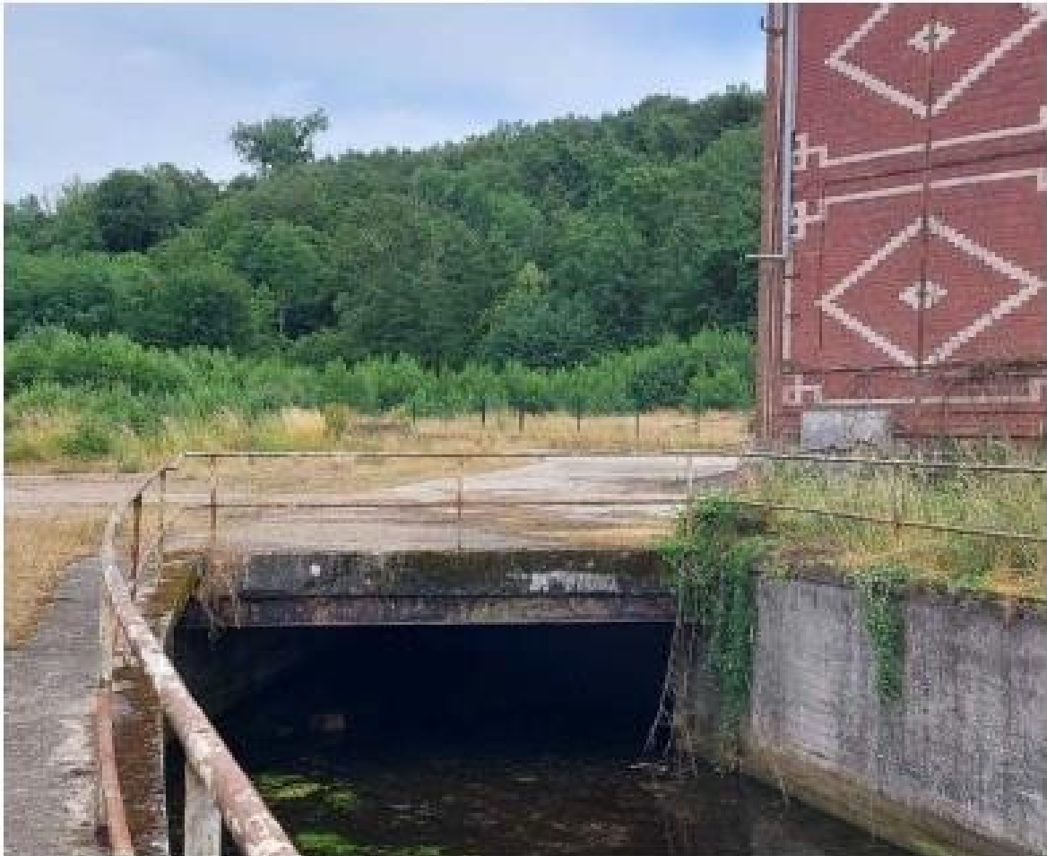
Photo existant dessous de bief à fermer
