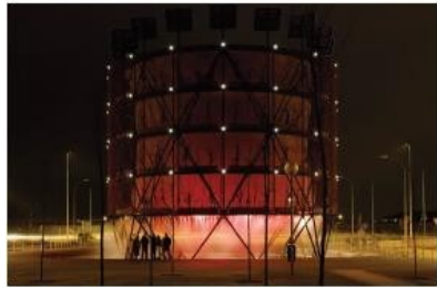
Mise en lumière de la cheminée
