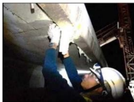
Matériel utilisé pour créer un SAR (en haut) et mise en place sur les fentes de l'ouvrage (en bas)
